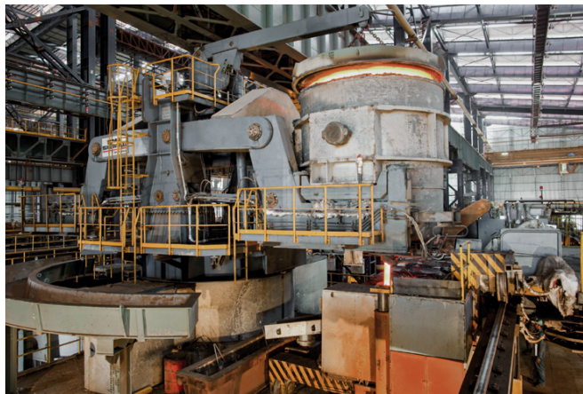
Impianto di colata continua
